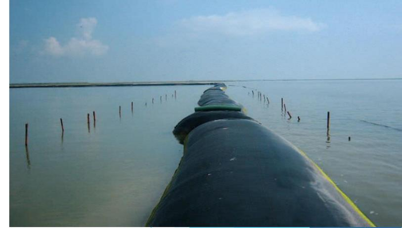
Géotube: tube en géotextile
